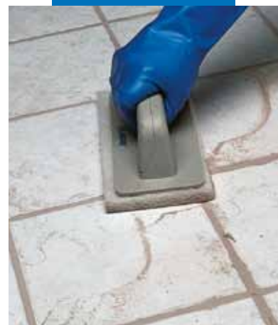
Konečné dočistenie so špongiou Scotch-Brite®
