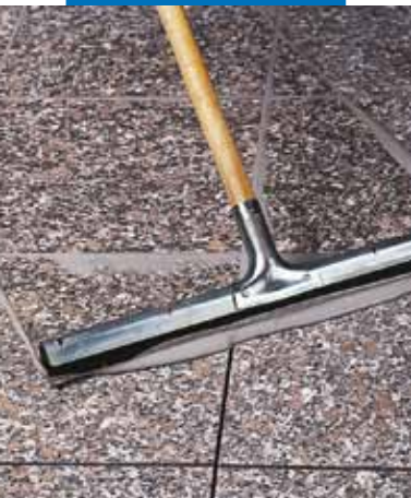
Škárovanie leštenej žuly špeciálnym, gumovým, podlahárskym náradím
