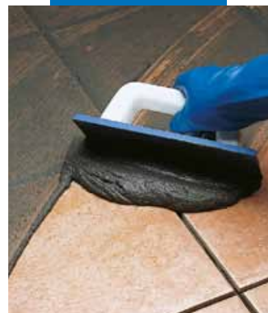
Škárovanie jeden krát vypalovanej dlažby s gumovou stierkou
