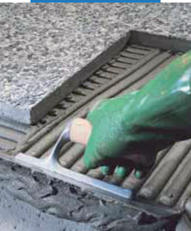
Lepenie vymývanej dlažby v exteriéri
