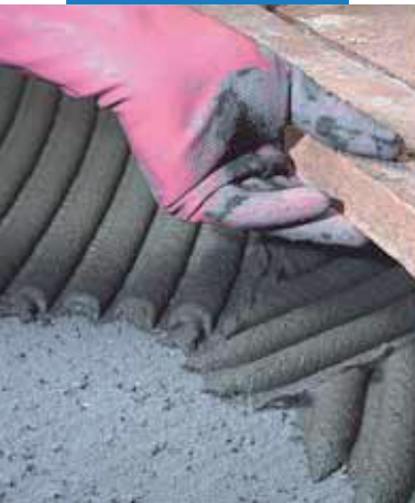
Lepenie ručne vyrábanej terracottovej dlažby na nerovný povrch
