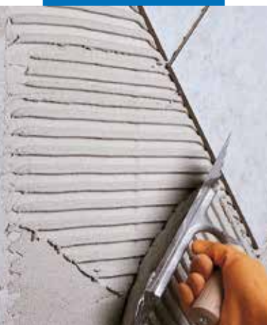
Inštalácia jeden krát vypaľovaných keramických obkladových prvkov na stenu vyhotovenú z pôrobetonových tvárnic
