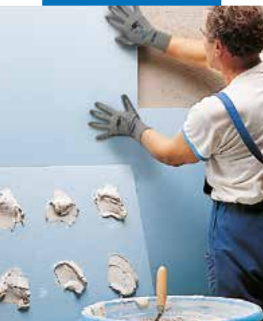
Lepenie tepelnoizolačných panelov z polystyrénu použitím lepidla Keraflex biely
