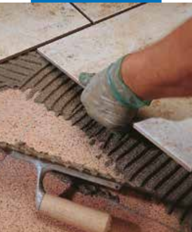
Inštalácia jeden krát vypaľovaných obkladových prvkov na stene vyhotovenej z terrazzo v exteriéri
