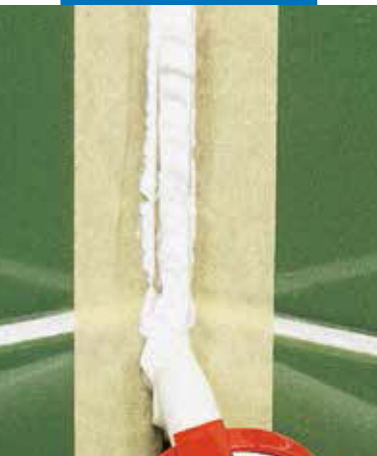
Nanášanie silikónového tesniaceho tmelu Mapesil AC
