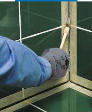
Nanášanie penetračného náteru Primer FD
