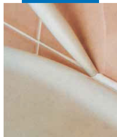
Tesnenie škár v styku so sanitárnym zariadením
