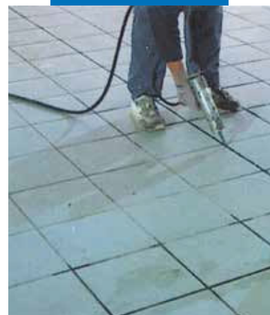
Tesnenie škár s tesniacim tmelom Mapesil AC v inštalovanej keramickej dlažbe
