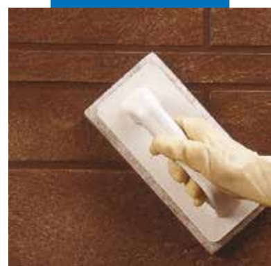
Čistenie škár s použitím Scotch-Brite® (po čiastočnom zatuhnutí)
