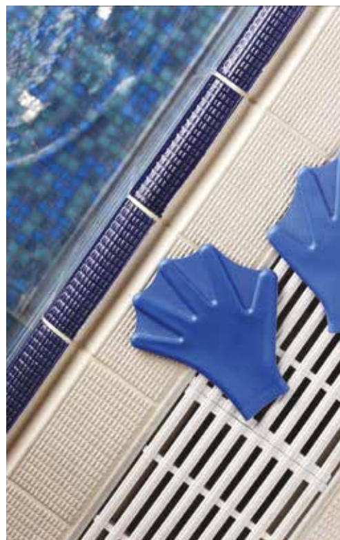
Plavecký bazén vyškárovaný s Ultracolor Plus
